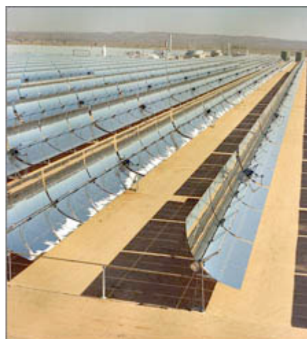
FIGURE 3 A Système Terrestre de Centrale Solaire Cylindro-Parabolique (Source: NREL 2006b)
