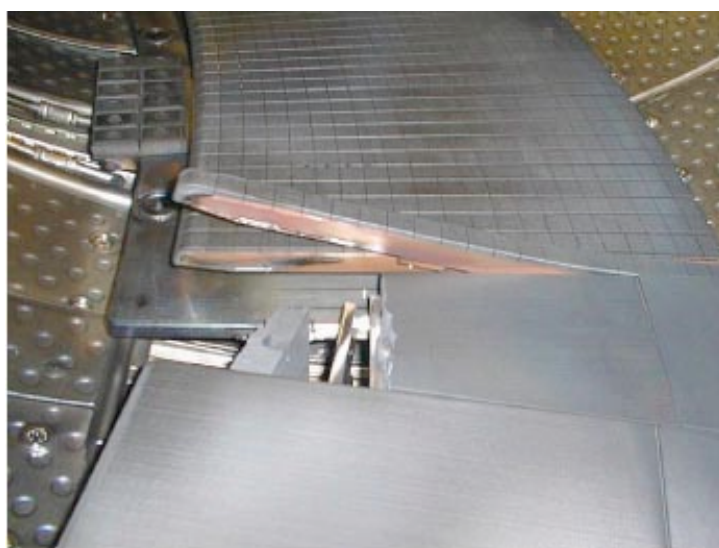
Structure pariétale de Tore Supra tordue par l'effet des courants induits.
